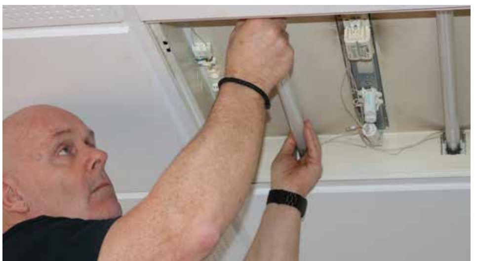
Jørn Kim Jensen stellt auf LED-Beleuchtung um, was zu einer jährlichen Einsparung von über 40.000 kWh geführt hat
