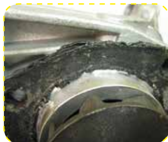
Wasserpumpe mit Ablagerungen aus flüssiger Dichtungsmasse im Kühlsystem
