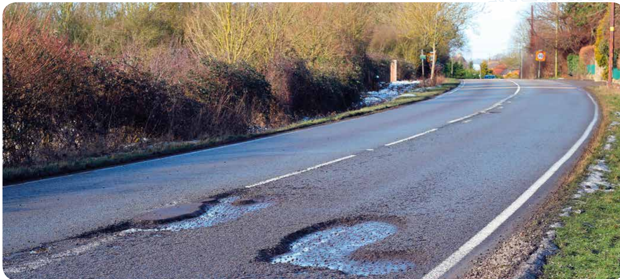
Det er ikke kun skaderne på vejbelægningen i form af huller, der naturligt nok er hård ved hele styretøjet og affjedringen
