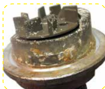
Utæt vandpumpe med spor af kalk i kølesystemet
